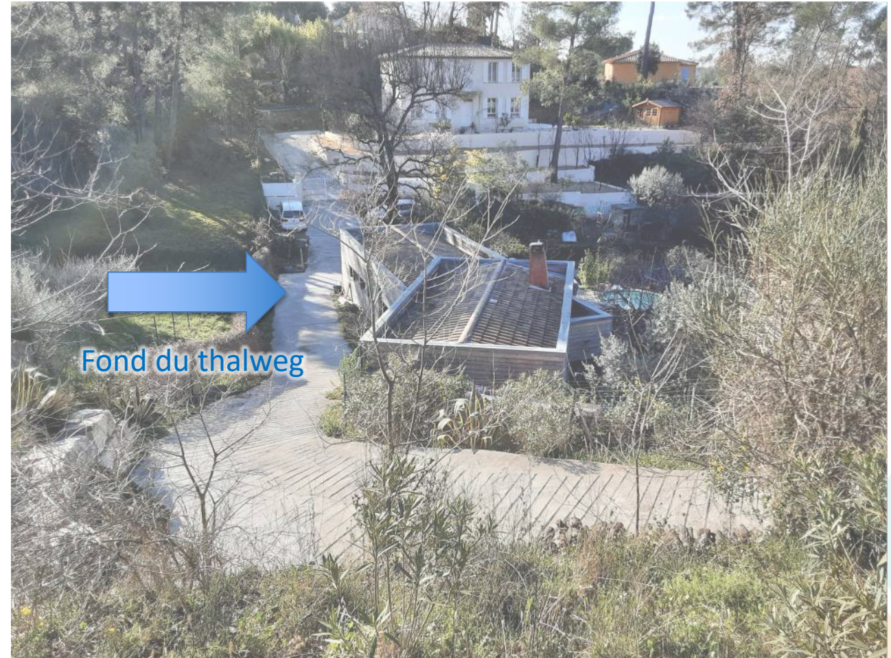
Exemple de construction « barrage » en fond de thalweg
