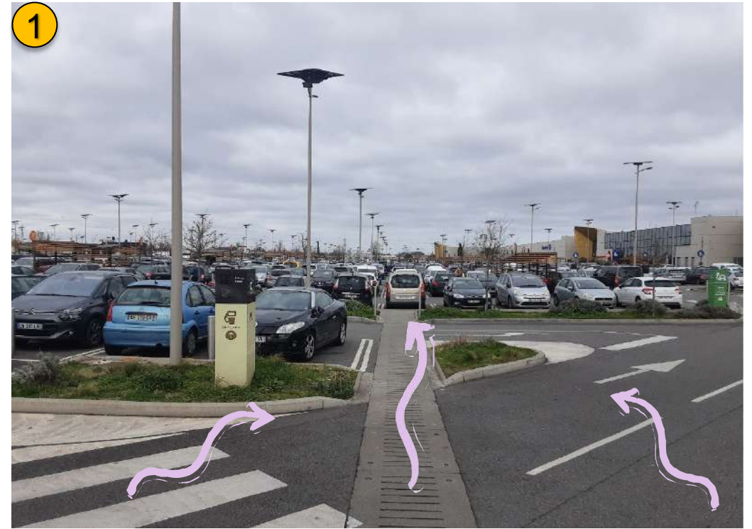
Vue vers l'aval de la zone de transfert/accumulation et un ouvrage de collecte des eaux pluviales sur le parking du centre commercial
